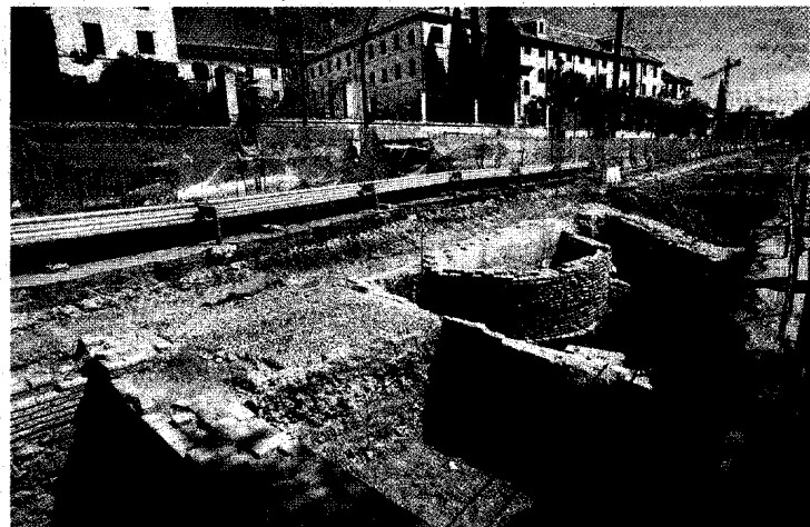
Obras en la Ribera donde han aparecido los hallazgos, en la zona de la Puerta del Puente
