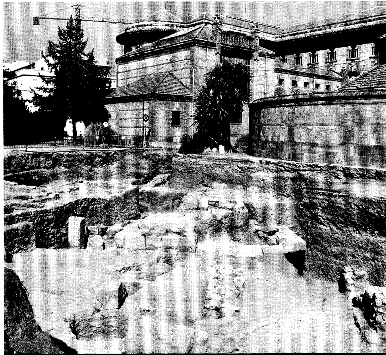
GRANDES RETOS. Imagen de una excavación en el entorno de antigua Facultad de Veterinaria.
